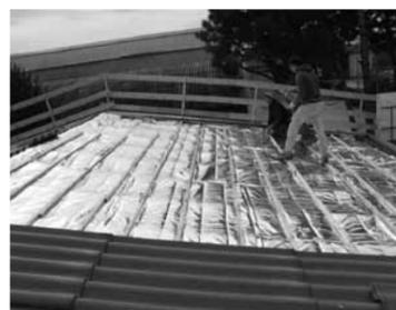
Figura 3 Isolamento sopracopertura
