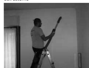
Figura 2 Insufflaggio nelle intercapedini dall'interno
