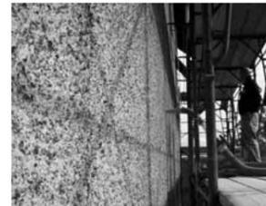
Figura 1 Insufflaggio nelle intercapedini dall'esterno
